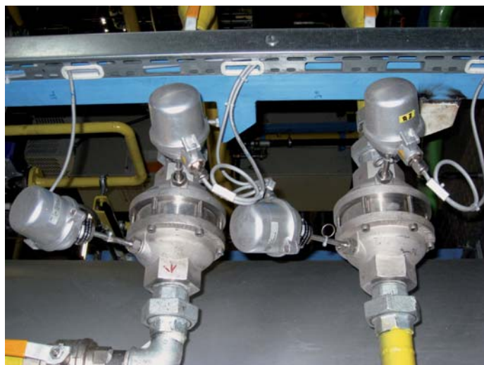
Bild 2: Bidirektionale, baumustergeprüfte Flammensperren
